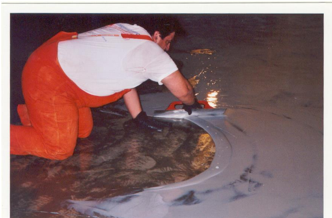
Διάστρωση βιομηχανικών δαπέδων
