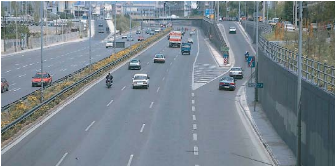
Σχ. 7.5γ Αυτοκινητόδρομος με λωρίδα επιβραδύνσεως.
