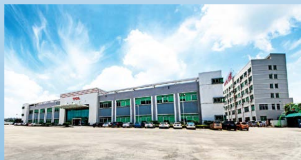
Jiujiang Base (2 εκ. σετ κλιματιστικών)
