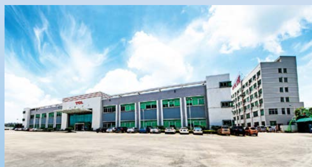
Jiujiang Base (2 εκ. σετ κλιματιστικών)
